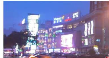
夜间照明不均，过度曝光
