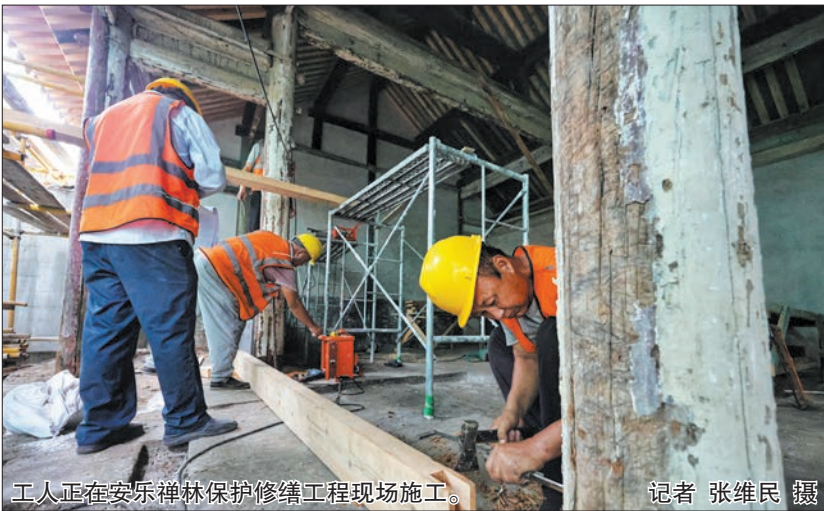
工人正在安乐禅林保护修缮工程现场施工。 记者 张维民 摄
