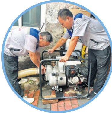
为应对强降雨天气,工作人员安装、调试抽水泵。京诚集团供图
