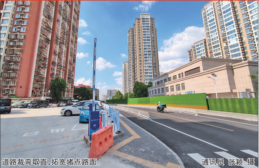
道路裁弯取直,拓宽堵点路面。
