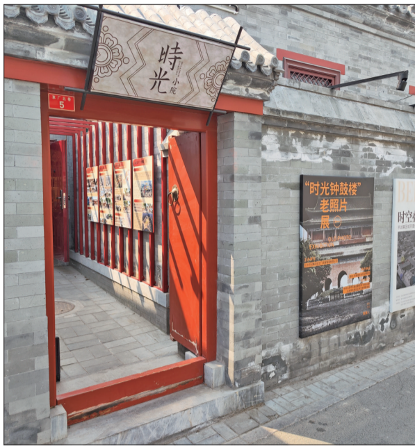
位于草厂北巷3-5号的观中·时光小院正式投入使用。
