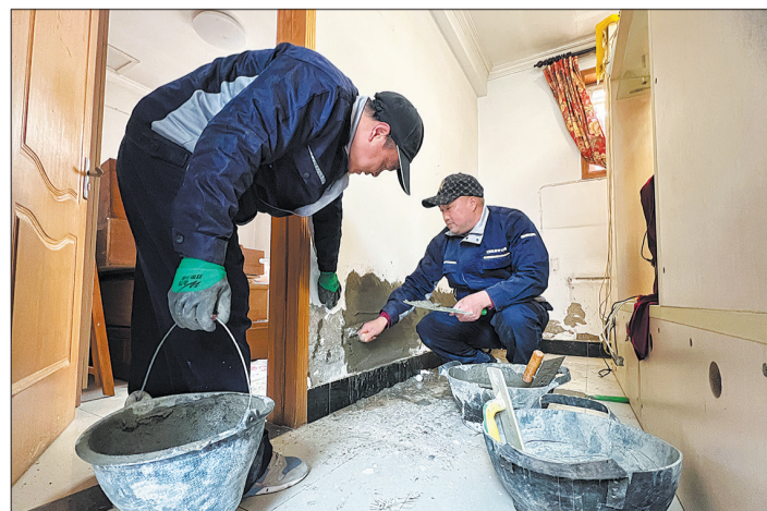
京诚集团施工队工人为平房居民修缮房屋。
