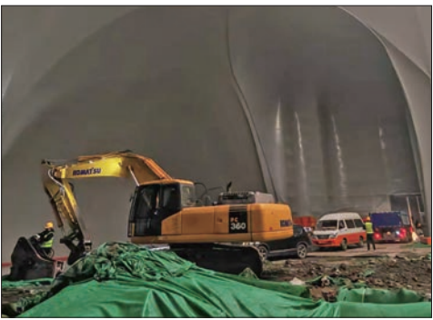
▲“直立式气承结构”基坑气膜亮相北京市外文书店升级改造项目现场。
