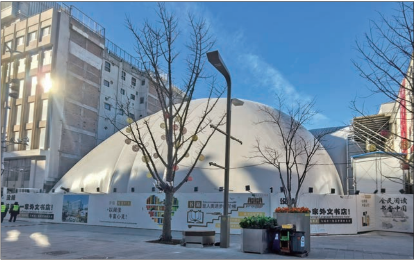
▲“直立式气承结构”基坑气膜亮相北京市外文书店升级改造项目现场。
