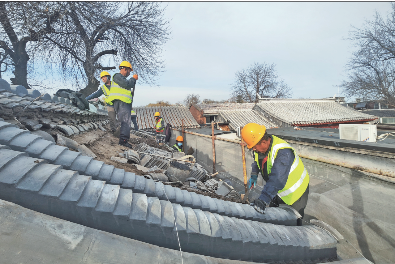
钟鼓楼湾26号已经完成木架及墙体砌筑工作,进行到房顶作业阶段。
