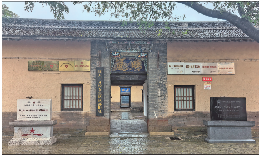
抗大一分校北岗旧址(岗上村旧址)。
