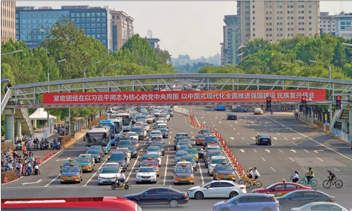
东单南过街天桥横幅。
