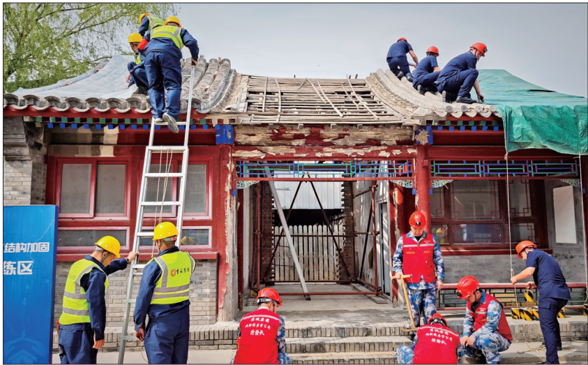
演习现场,抢险队员们进行房屋木结构加固演练。
