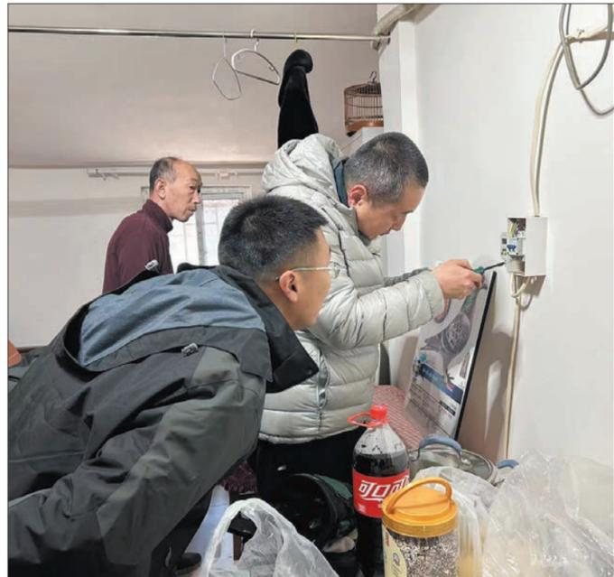
工作人员在安全巡检过程中检查电采暖器空开线路。
