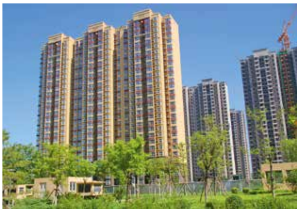
2023年，东城区加大供给满足需求，新建成保障性住房1100余套（佳源公司提供）
