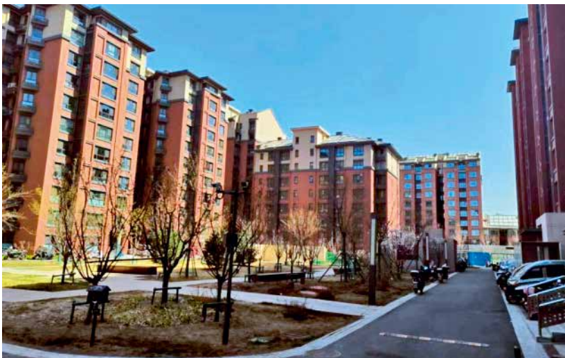
2月1日，望坛棚户区改造项目成果实景图（区住房城乡建设委提供）
