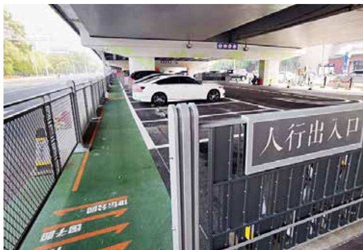
2月，雍和宫桥下提升工程完工后增加停车位（邓伟摄）
