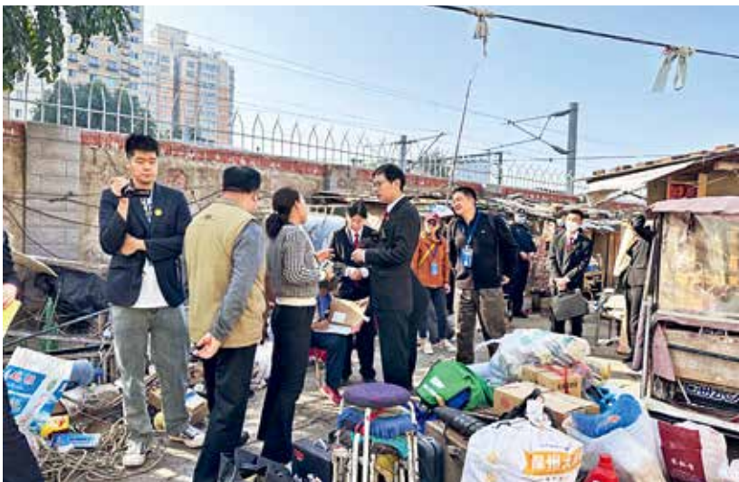
10月25日，永定门外街道开展铁路沿线“疏整促”拆除违建工作 (永定门外街道提供)
