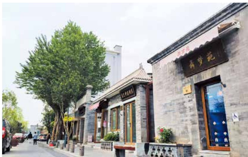
5月，南中轴西草市街全线实现架空线入地，“剧装一条街”亮出美丽天际线(区域管委提供)
