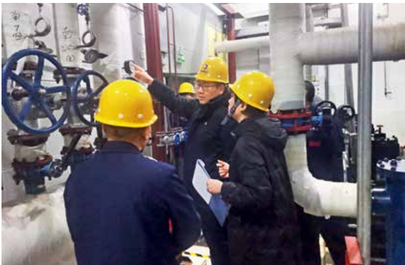
11月11日，区城市管理委供热办开展供热锅炉房安全检查 (区城市管理委提供)
