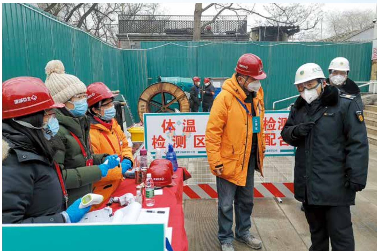
3月30日，区应急管理局执法监察人员对在建项目开展防疫和安全检查（李冬梅摄）
