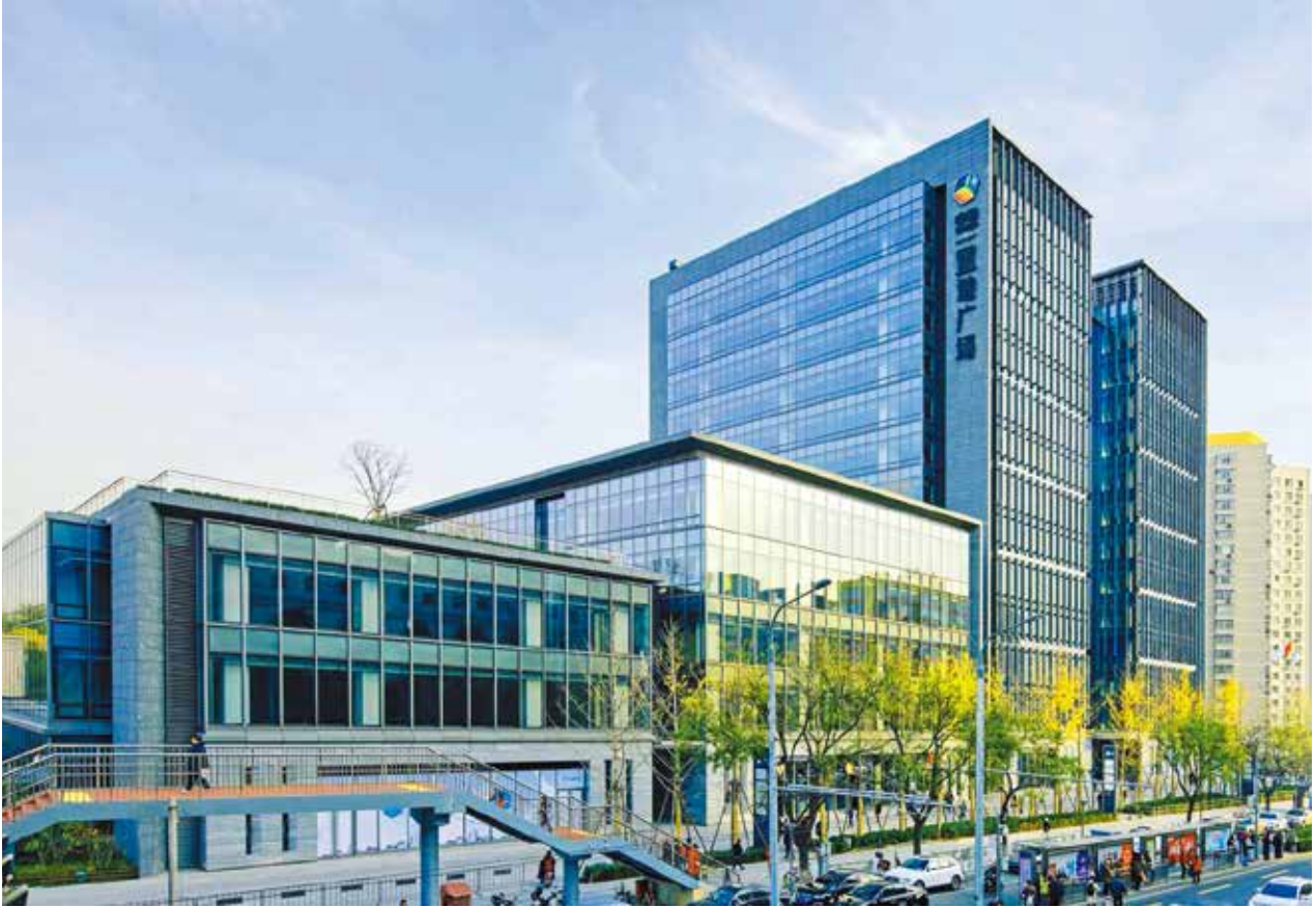
1月20日，中粮·置地广场改造提升后成为5A国际甲级写字楼，是东城区楼宇改造的典型案列（庄蕊摄）
