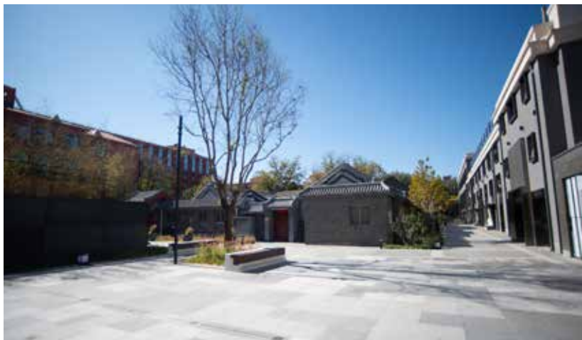
10月23日，王府井大街277号院完成空间改造升级（李婉摄）
