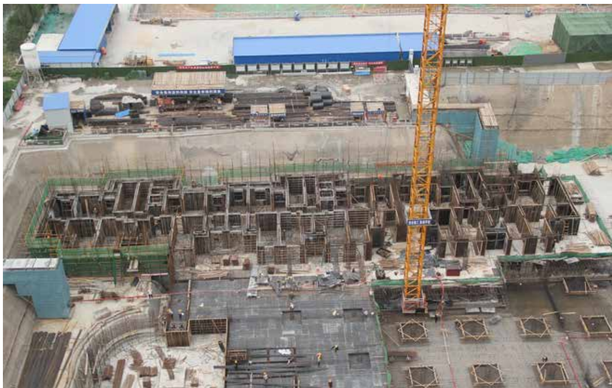
9月，豆各庄保障房工程项目205号楼开工（区住建委提供）
