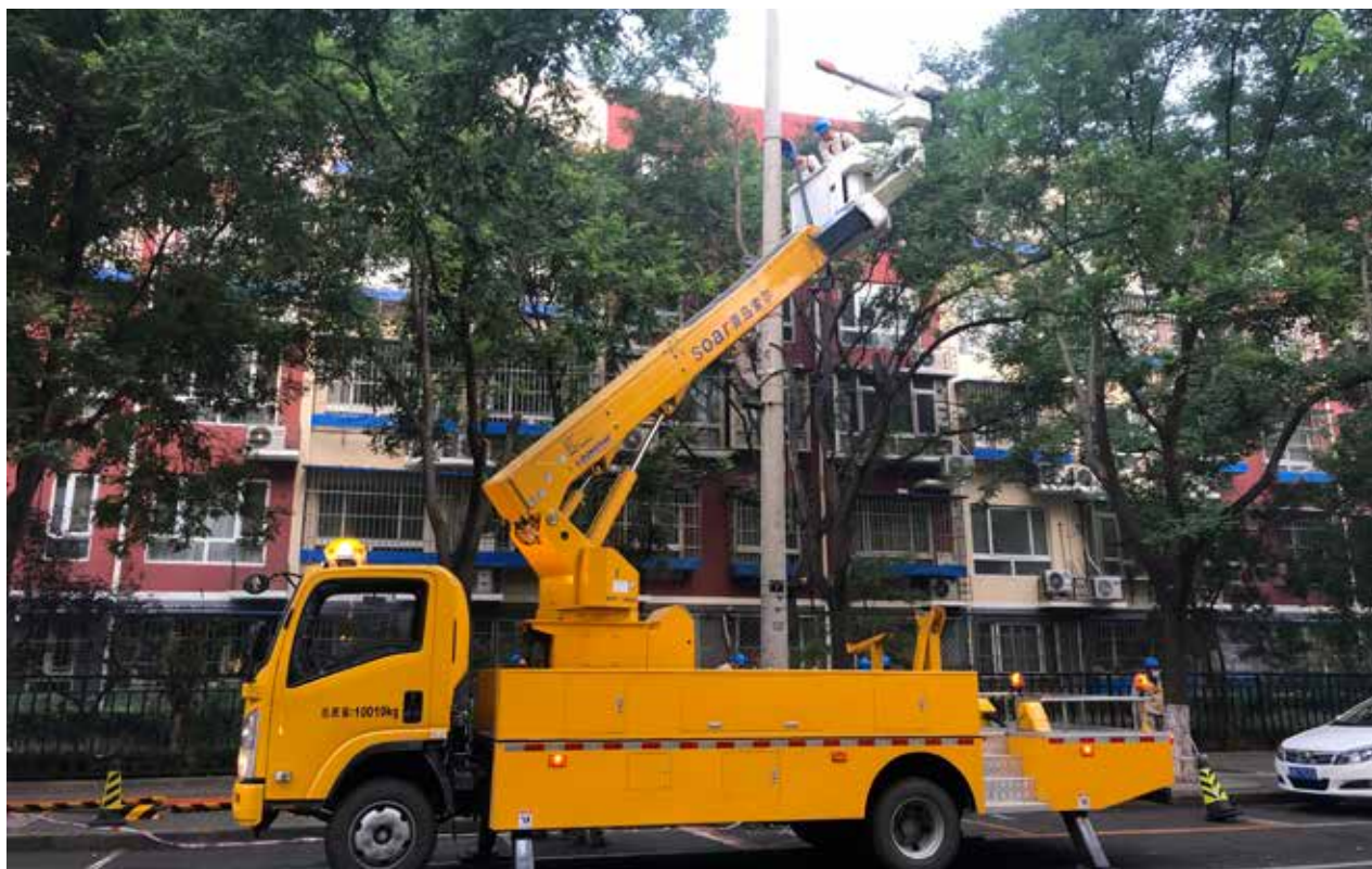
8月28日，国网北京城区供电公司设备部组织龙潭路K3198运行击穿应急处理抢修（罗中戈摄）
