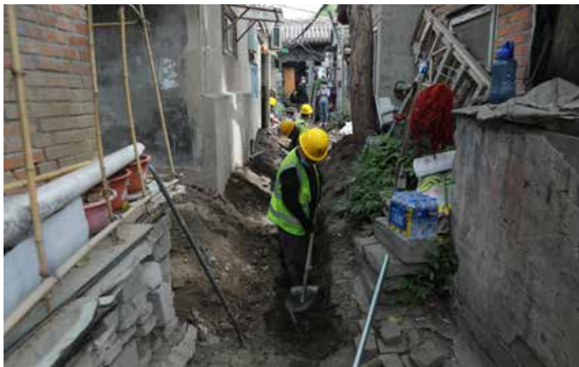
6月16日，东华门街道黄城根南街32号院“一户一表”项目施工现场（马铮摄）
