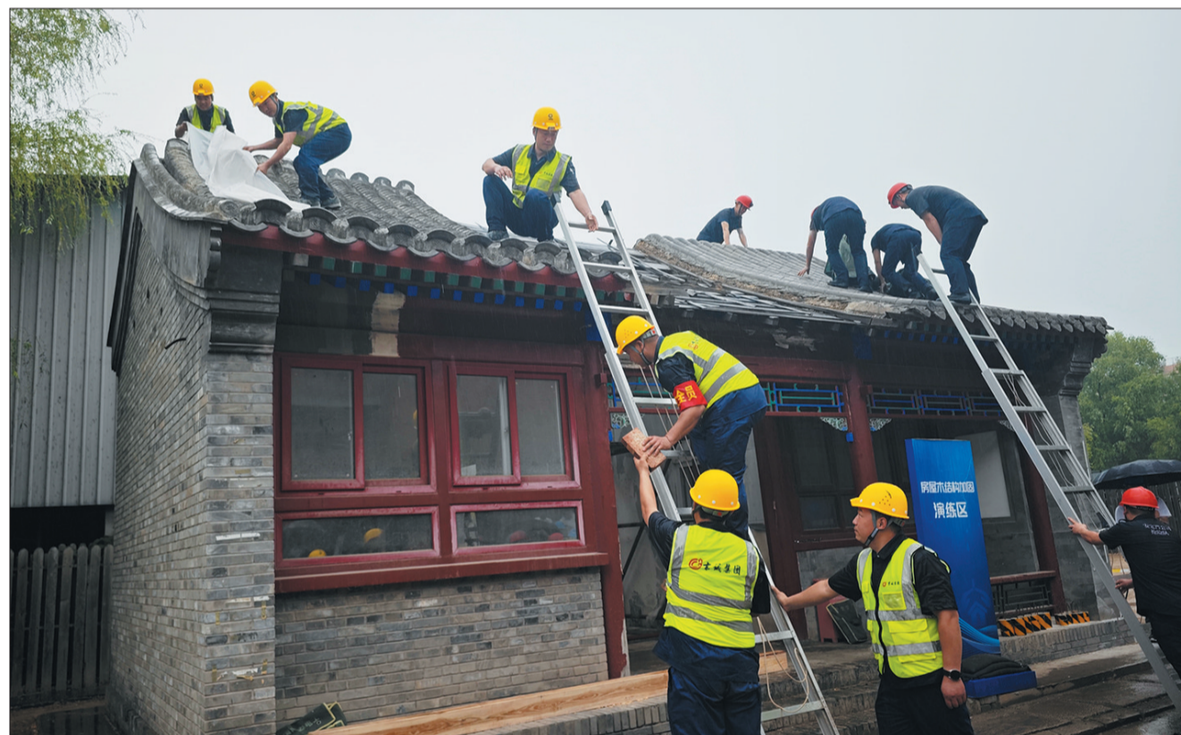
抢险队员正在进行房屋应急抢险防汛演习。
