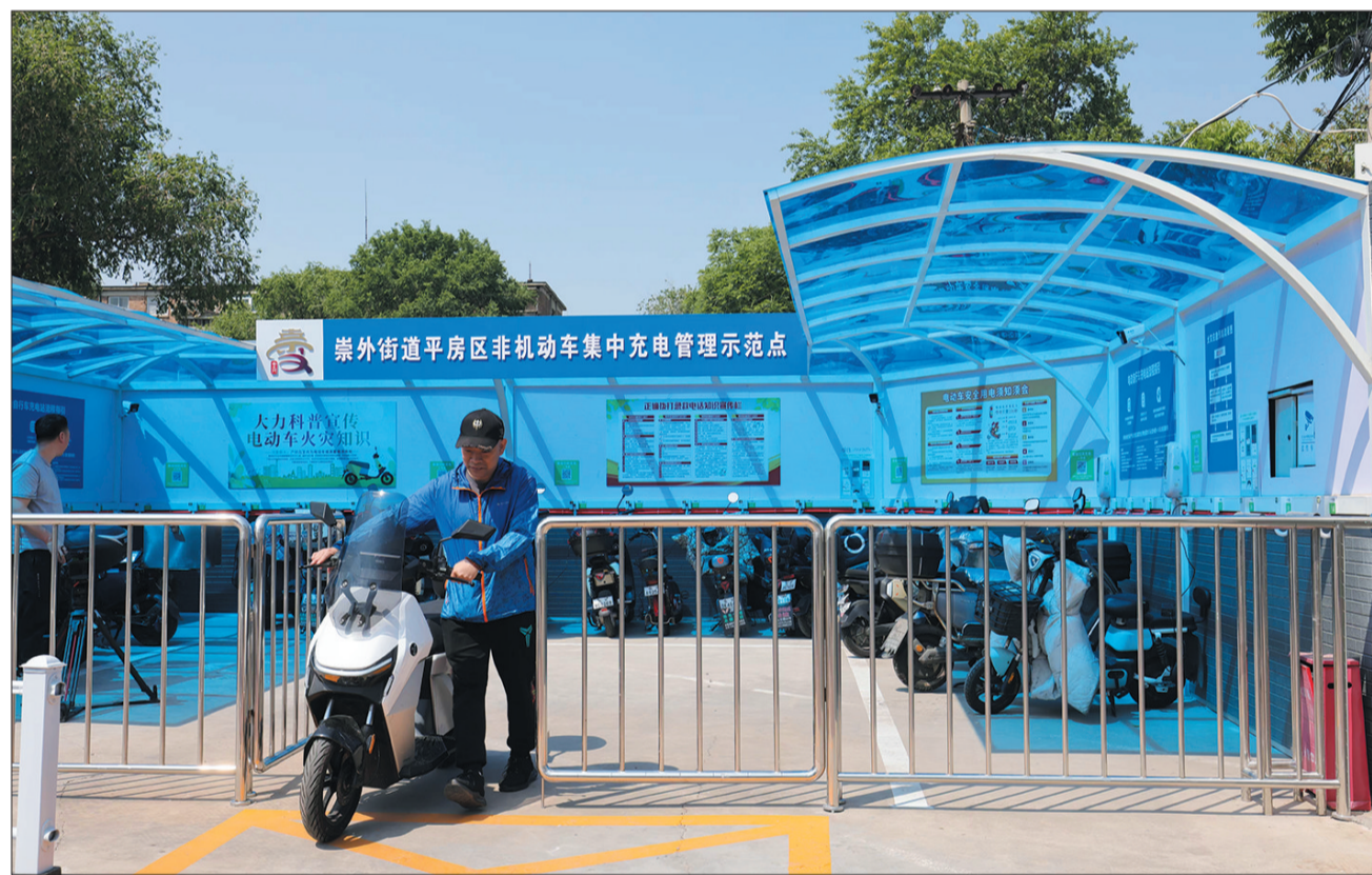
位于祈年大街西侧的非机动车集中充电点投入使用。
