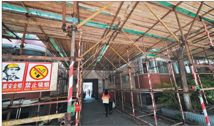
景泰东里小区正在进行老旧小区综合整治。
