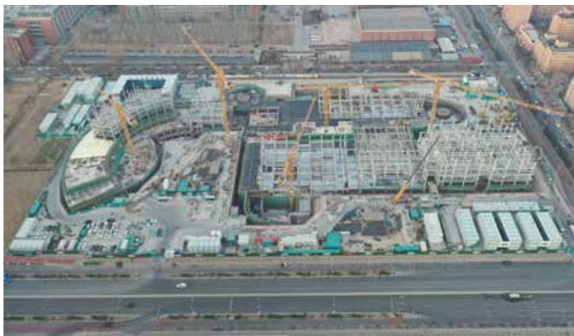
5月，北京口腔医院迁建工程启动主体结构施工（北京口腔医院提供）
