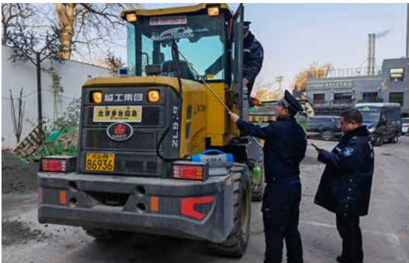
12月22日，东城区综合执法大队对辖区内施工工地进行非道路移动机械检查（邢鲁源摄）
