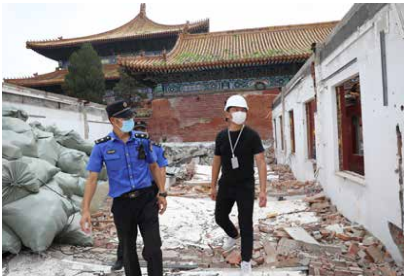
8月4日,东华门执法一队拆除太庙内1000余平方米临时建筑(刘满清摄)
