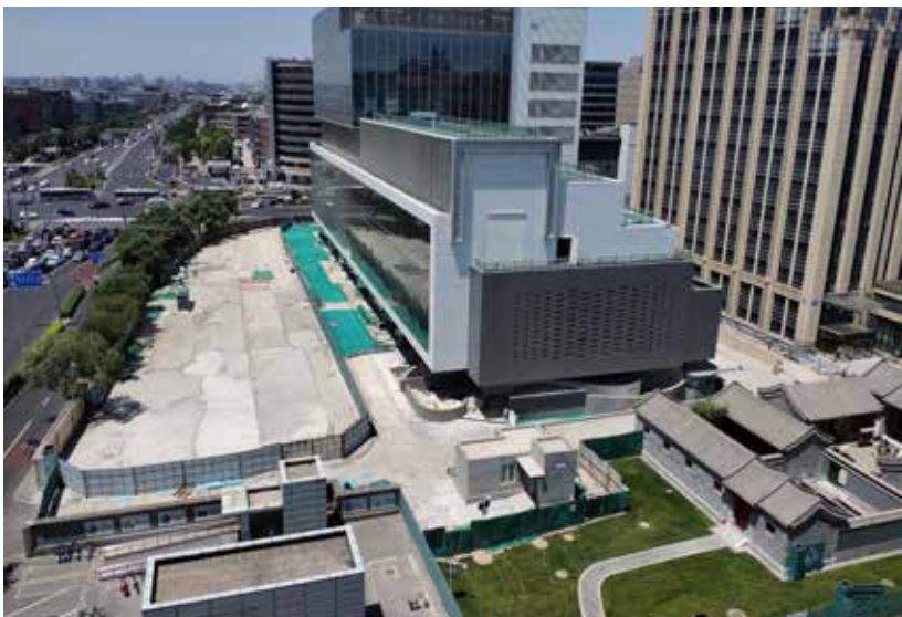
8月19日，新景商务楼项目竣工（区住建委提供）
