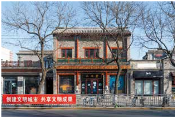
1月，永安堂药店恢复典型的传统拍子式铺面房，这是东四北大街最传统、类型较多的商业建筑形式（闫文摄）
