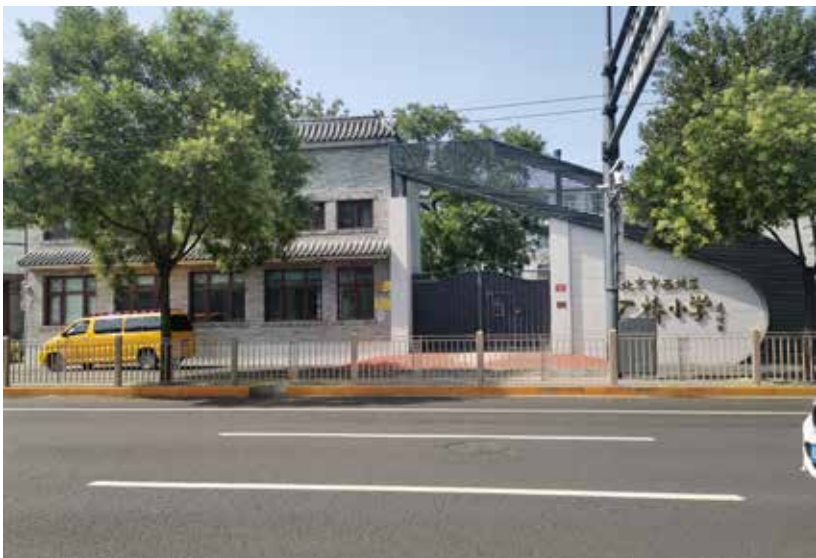
2021年，筑邦公司完成平安大街整治提升项目（杨小伟摄）
