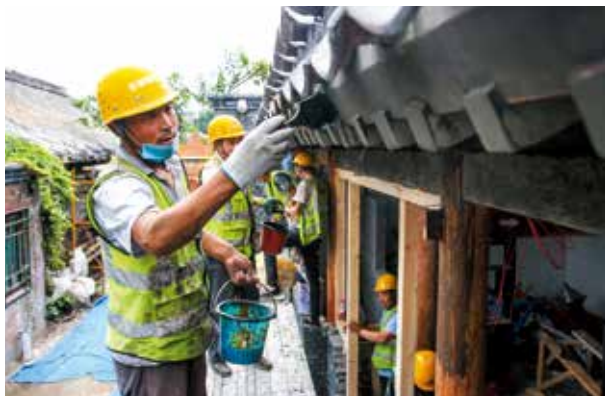
6月，工人在雨儿胡同进行修葺提升（区融媒体中心提供）
