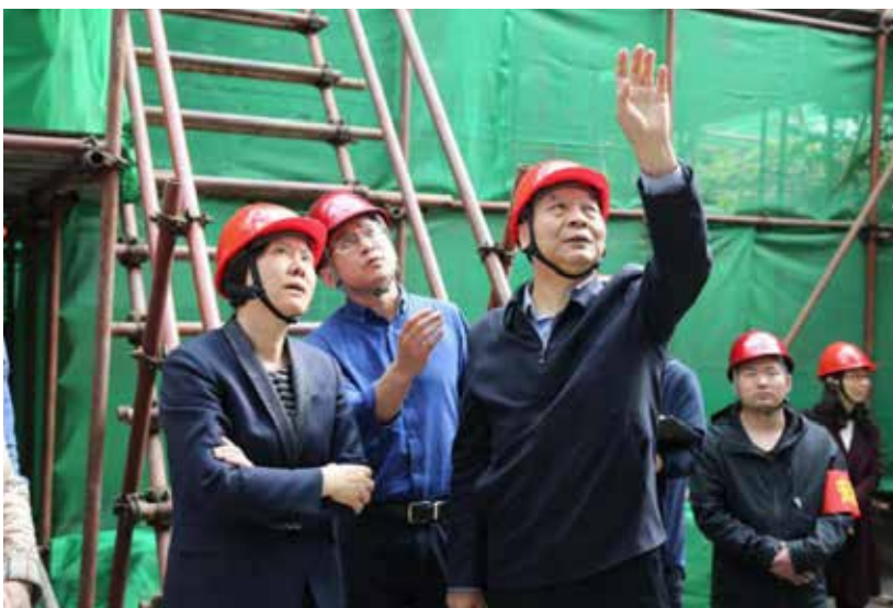
4月19日，全国妇联主席视察中华女子学院贤良祠古建维修工程（马慧光摄）
